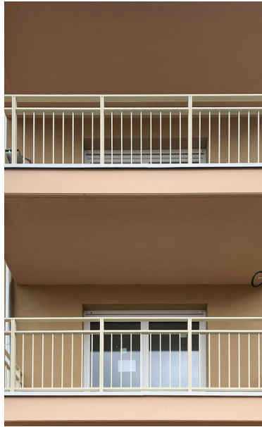
Barreaux sous main courante
