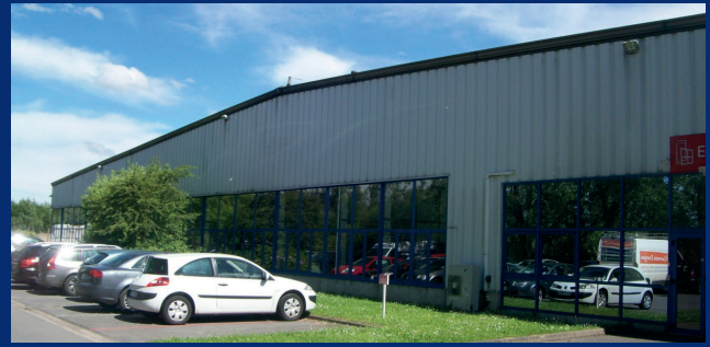
Fabrication de l'Aluminium - 10 000 m 2 - Nord (59)
